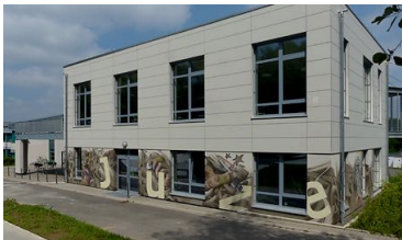
Neues Photovoltaikprojekt in Lohmar
