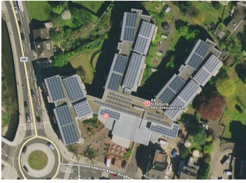
Die technisch aufwändige und in der Überwachung komplexe Photovoltaikanlage auf dem Seniorenzentrum in Siegburg
